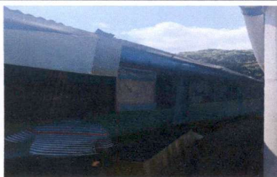
Foto 5: Sustitución de canal de metal del modulo 1 del establecimiento.
