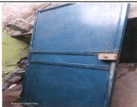
Foto 2: Lijado y cambio de chapa de la puerta 3 modulo 1 del establecimiento.
