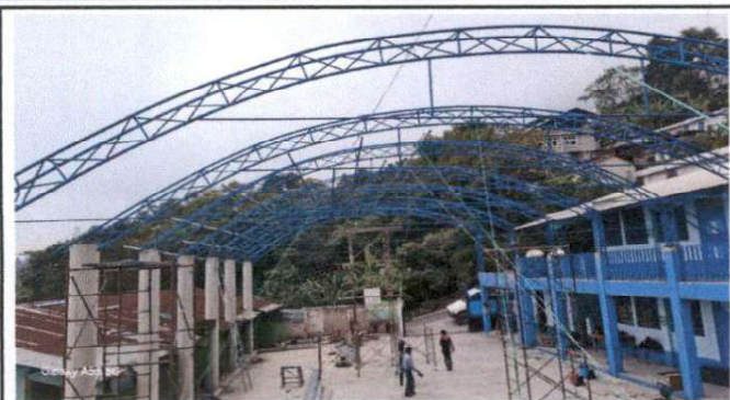
Foto 1: Armadura de sustitución de estructura de soporte de metal para el techado del patio del establecimiento.
