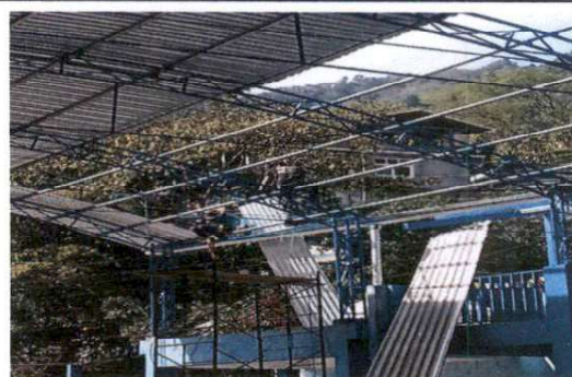
Foto 6: Sustitución de lamina por lamina troquelada aluzinc del techado del patio del establecimiento.
