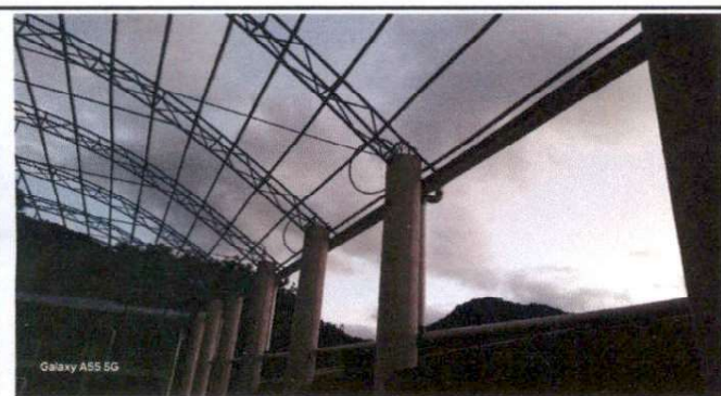
Foto 3: Colocación de canal y bajadas de agua pluvial del techado del patio del establecimiento.
